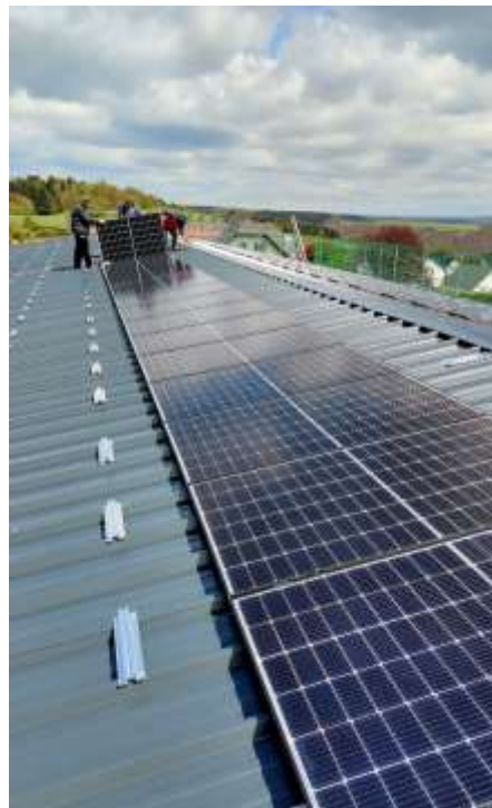
Abb. 1 - Aufbau der 100 kWp-Anlage
