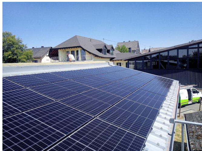
Schnappschuss vom Modulaufbau unserer 9. PV-Anlage (08. 2020)
